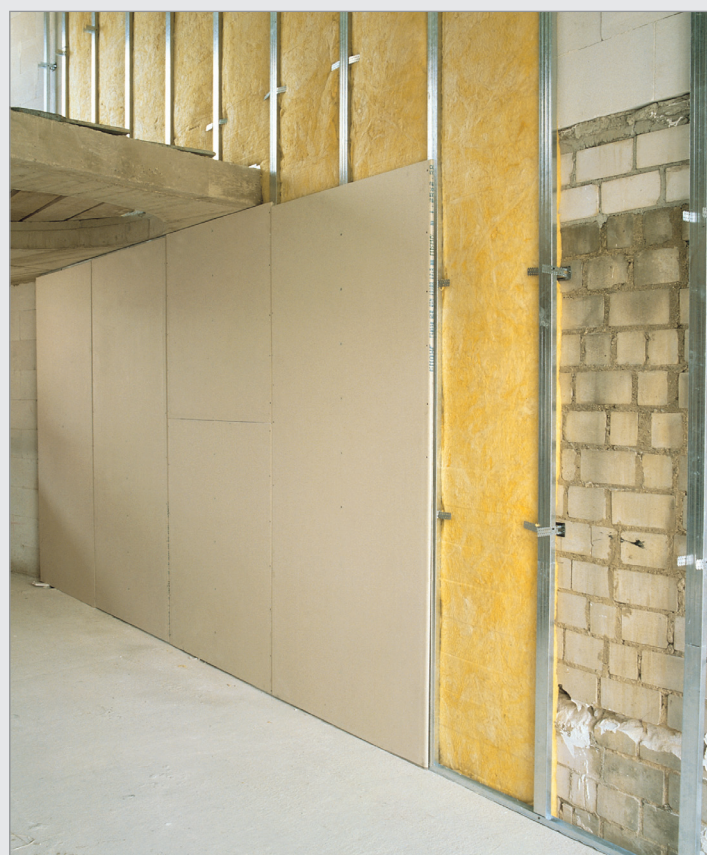
عایق کاری جدار ساختمان با دیوار پوششی
