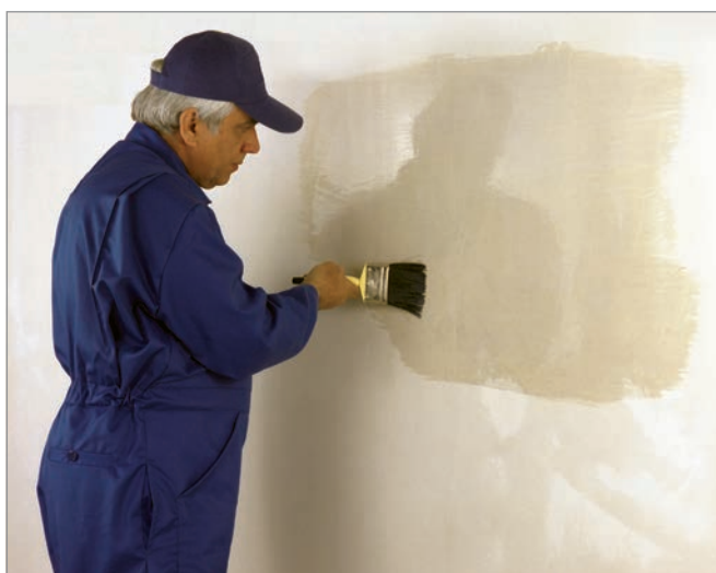
اجرای لایه پرایمر بر روی ماستیک قبل از رنگ آمیزی با رنگ روغنی
