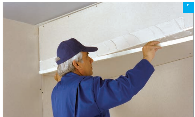
قرار دادن نوار درزگیر بر روی بتونه
