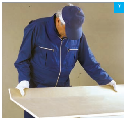
شکستن پنل در محل برش
