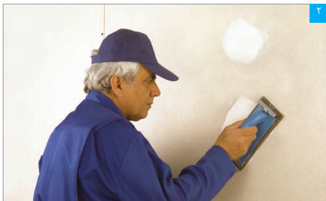
پرداخت سطح بتونه خشک
