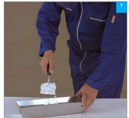
ریختن پودر بتونه در آب
