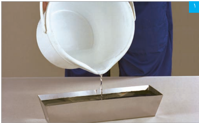
ریختن آب در ظرف تهیه بتونه
