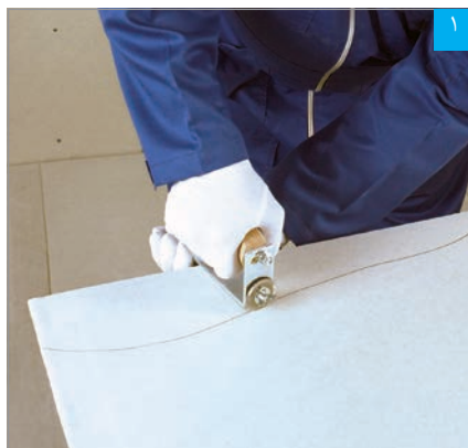
اجرای برش موج‌دار با دستگاه برش قرقه‌ای
