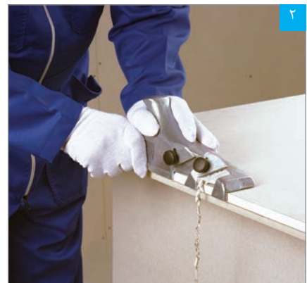
اجرای پخ با پخ زن
