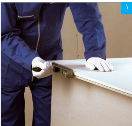
پرداخت لبه برش‌خورده با رنده
