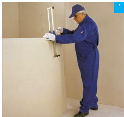
برش پنل با دستگاه برش طولی
