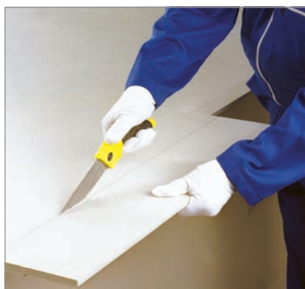
برش پنل با اره دستی
