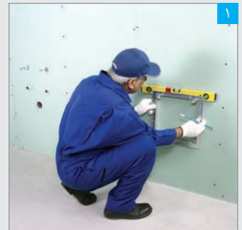
۱ علامت گذاری محل نصب دریچه (با استفاده از قاب دریچه)
