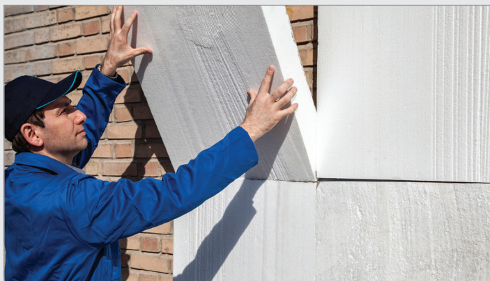
نصب قطعات عایق بر روی دیوار زمینه
