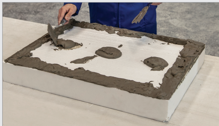
نشان دادن چانه‌های چسب سیمانی مخصوص بر روی قطعات عایق
