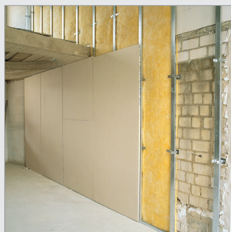
عایق‌کاری حرارتی و صوتی دیوارهای خارجی ساختمان
