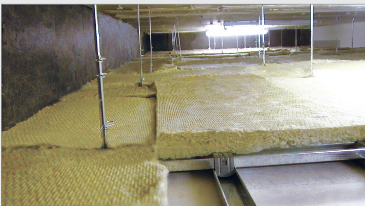
عایق کاری پیلوت
