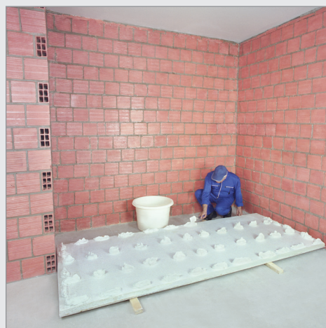
نشان دادن چانه‌های اسکیم‌لایت بر روی پنل‌ها
