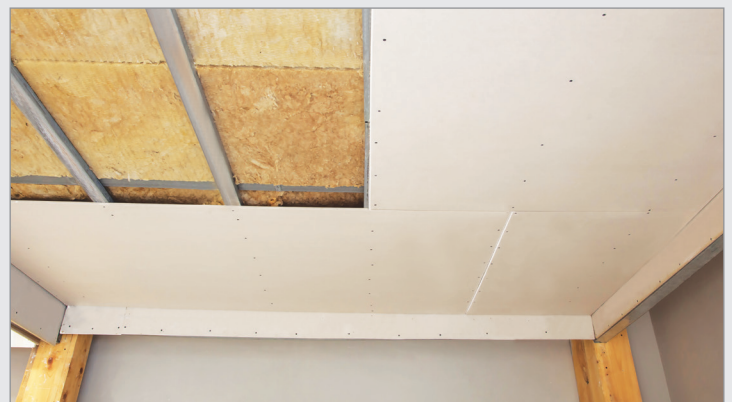
عایق کاری سقف ساختمان
