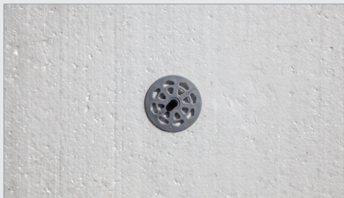
نصب بست‌های Termofix
