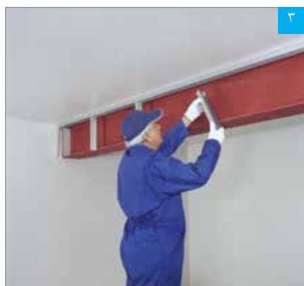
اجرای سازه‌های قائم
