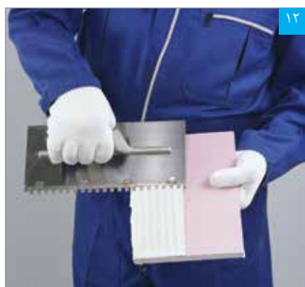
اجرای بتونه درزگیر بر روی نیمی از پنل پشت بند درز (با استفاده از مالنه دندانه‌دار)
