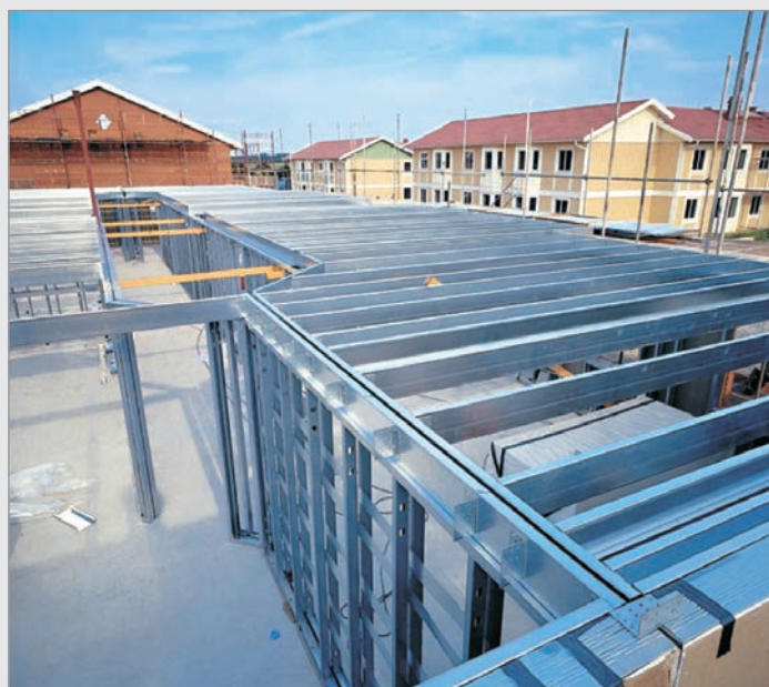
شکل ۳۰: سیستم سازه فولادی سبک (LSF)
