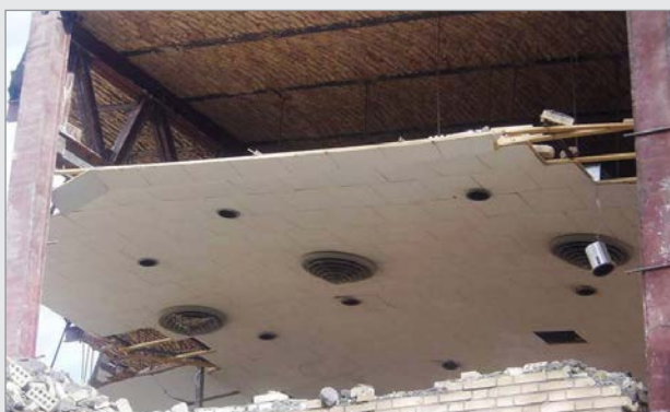
شکل ۱۶: اجرای سقف‌های کاذب با روش سنتی
